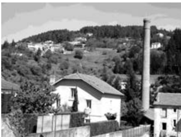
Figure 1 : cheminée de l'ancienne usine Progil se dressant majestueusement face à la villa qui fut celle des Villez père & fils, directeurs de l'usine de 1910 à 1962. (Photo G.C.)
