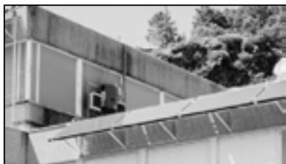
Installation de panneaux photovoltaïques en brise-soleil
