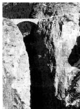
Le pont du Châtelet, à 102 m au dessus de l'Ubaye, qui a désenclavé Fouillouse.
